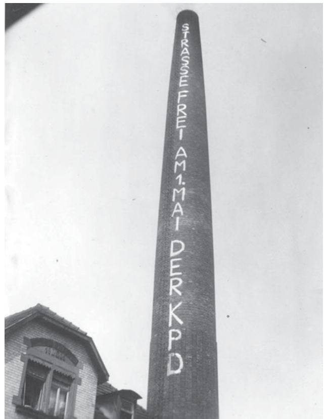
Ein Schriftzug zur Mobilisierung für den 1. Mai auf dem Schornstein einer Fabrik in Stuttgart 1929.
